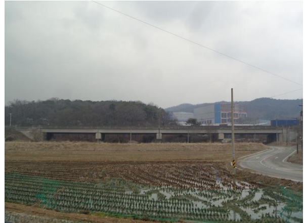
교량 측면 전경
