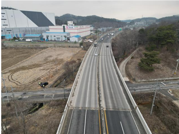
교량 상부 전경
